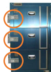
既存薬品庫取り付け例
